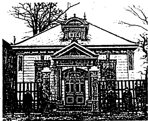
写真4 竣工なった閲覧室
